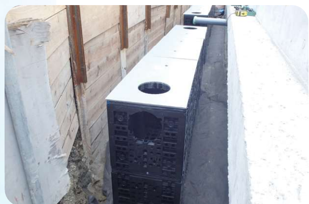
〈リスレインスタジアムII某鉄道駅工事(トレンチ仕様)〉
